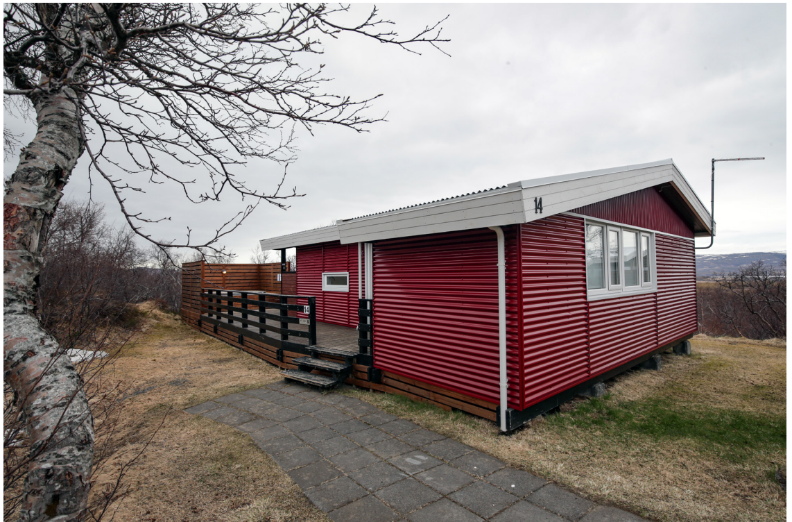
Úr sumarbústaðabyggðinni á Einarstöðum.
